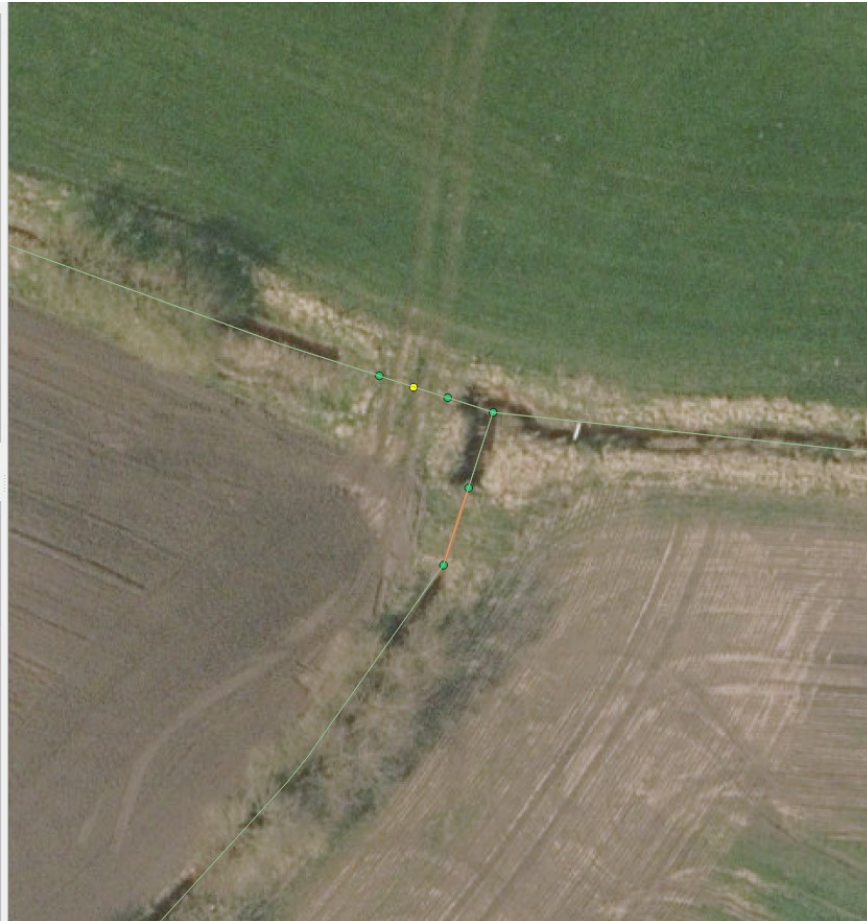
Figur 12 To rørlagte vandløbssegmenter ved markoverkørsler, hvor kun det ene (orange) er blevet automatisk korrigeret. Gul prik er fejlmarkeringen på det andet.
