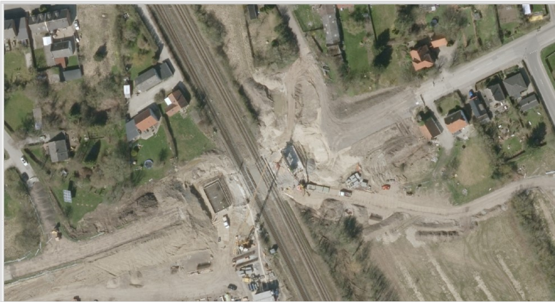
Figur 5 Midlertidig nedlæggelse af vej under renovering bro
